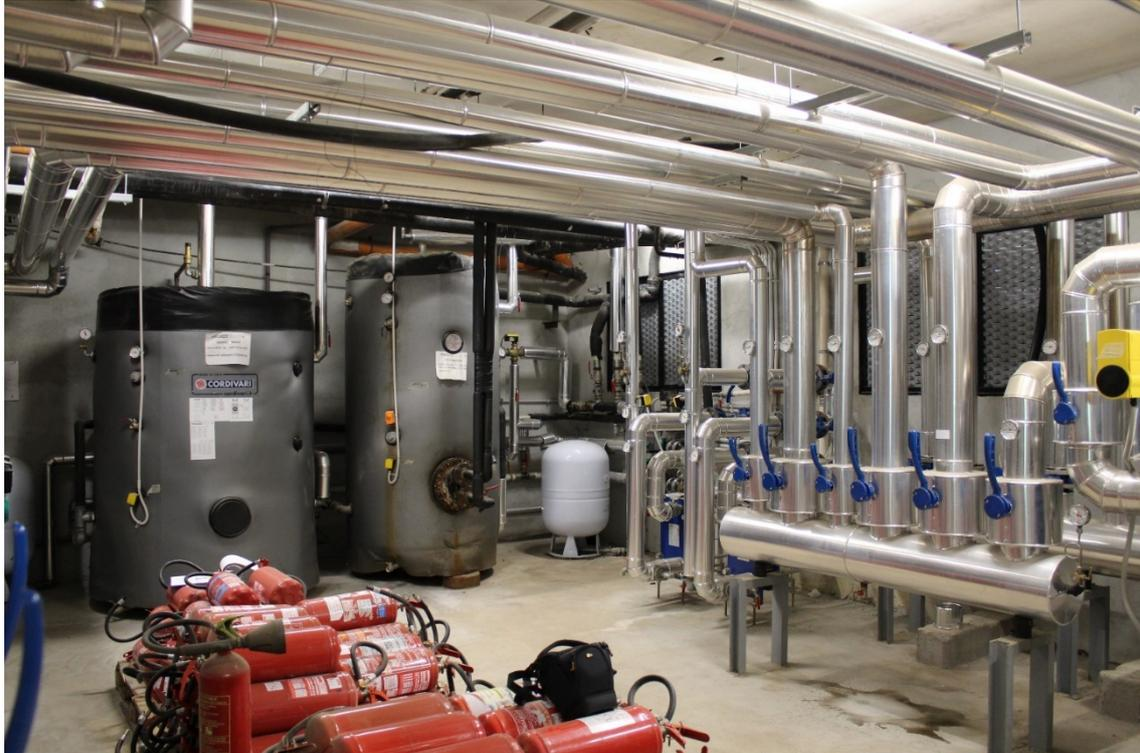
Figura 4: Serbatoi di accumulo acqua calda
